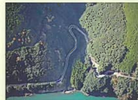
国道169号の線形不良区間
