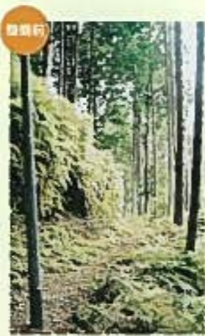
国道169号交通不能区間（整備前）
