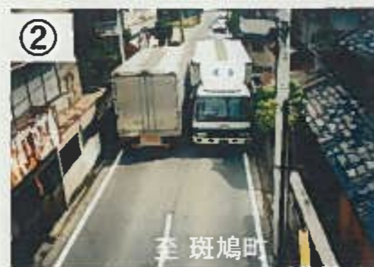
写真2 (大型車のすれ違い困難状況)
