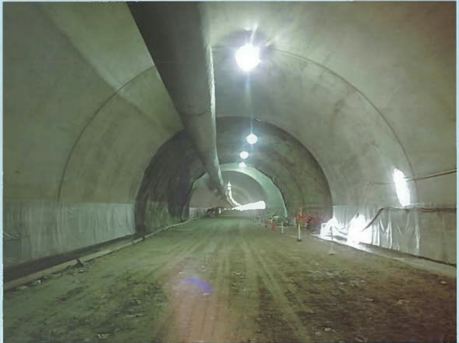
写真：水泥トンネル建設現場（御所市五百家） ※構造物名称は仮称です。
